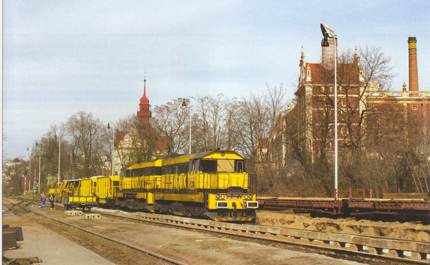
Na obnově železniční stanice Praha-Braník se podílely i motorové lokomotivy společnosti Viamont.
