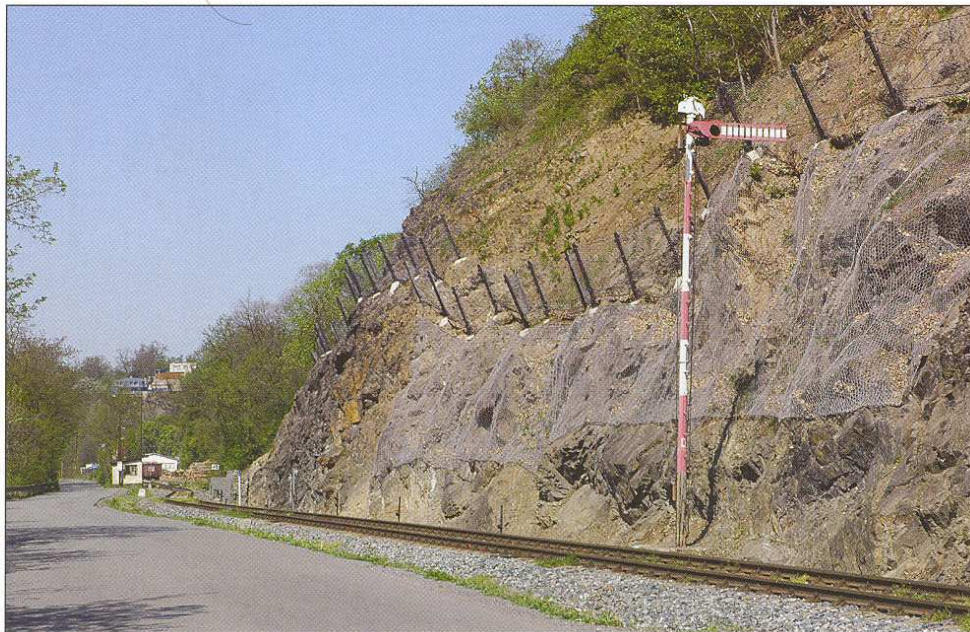
Nestabilní svah nad tratí u vjezdového návěstidla do Zbraslavi ze směru od Vraného nad Vltavou byl zajištěn při podzimní výluce roku 2006.
