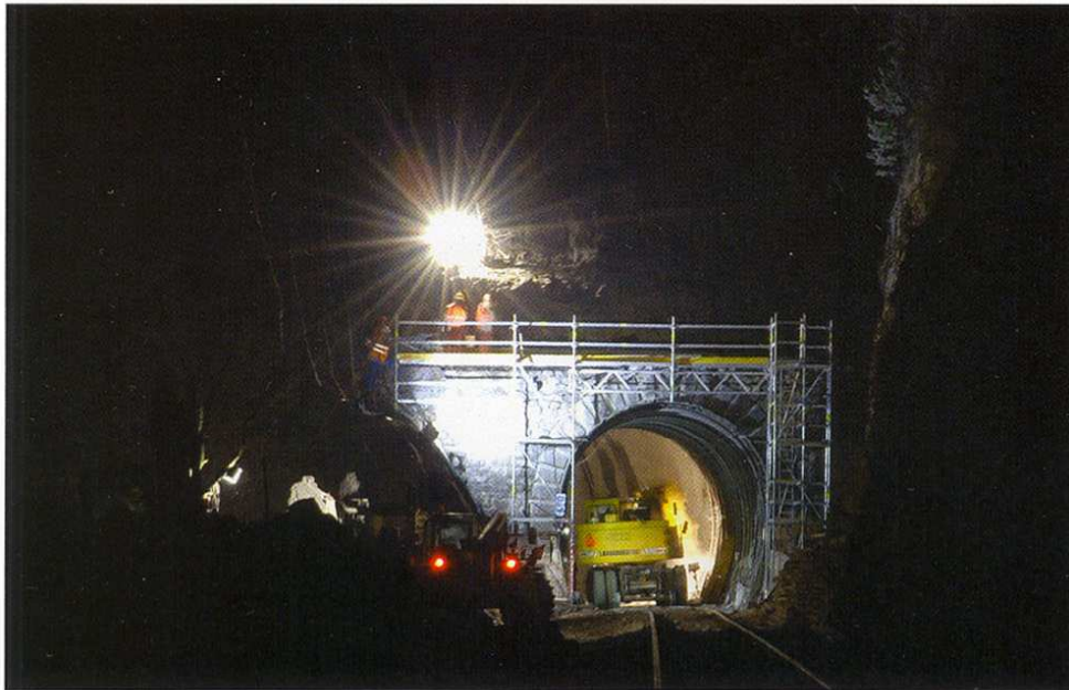
Noční záběr na vranský portál Jarovského tunelu, jehož oprava proběhla v termínu od 5. listopadu do 20. prosince 2007.
